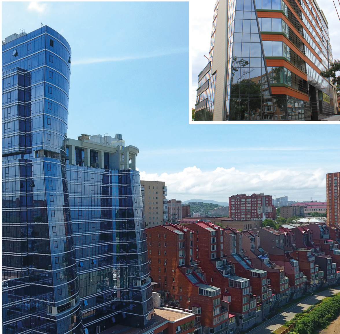
■ ЖК "Gavan Residence" г. Владивосток. Структурное остекление.
